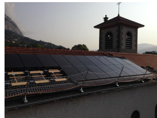
Le toit de St Ferjus en phase d'installation en août 2017, merci à Enercoop et Energ'Y citoyennes pour la photo.
