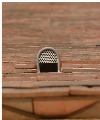
De petites ouvertures de 6 cm ont été aménagées entre les tuiles du toit. Une colonie d'Oreillard les utilise pour ses va et vient et s'est bien établie dans les combles.
